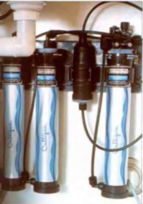
перед ней, следует менять каждые 4–6 месяцев. Мембрана может фильтровать частицы размером в 1/10000 микрона (невооруженным глазом видны объекты размером в 40 микрон и более!), поэтому фильтрация идет медленно и сохраняется лишь одна часть чистой воды из пяти, а остальная вода идет на слив. Система не требует подключения к электросети; стандартный фильтр на основе обратного осмоса работает при давлении водопроводной воды в 2,8–7,0 кг/см<sup>2</sup>.
